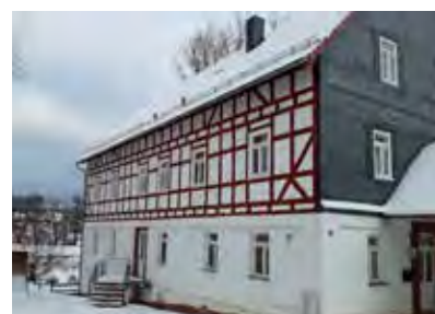
Gut erhaltene Bausubstanz
