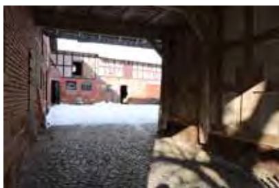
Blick in einen Vierseithof
