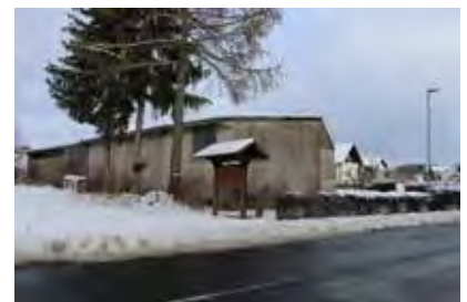
Halle mit Eternitverkleidung
